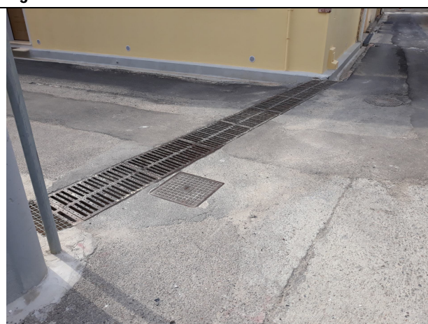
Figura 19. Particolare delle caditoie sulla Via Franklin
